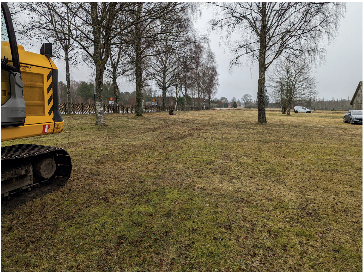
Figur 4. Platsen innan schaktning. Foto från NNV
