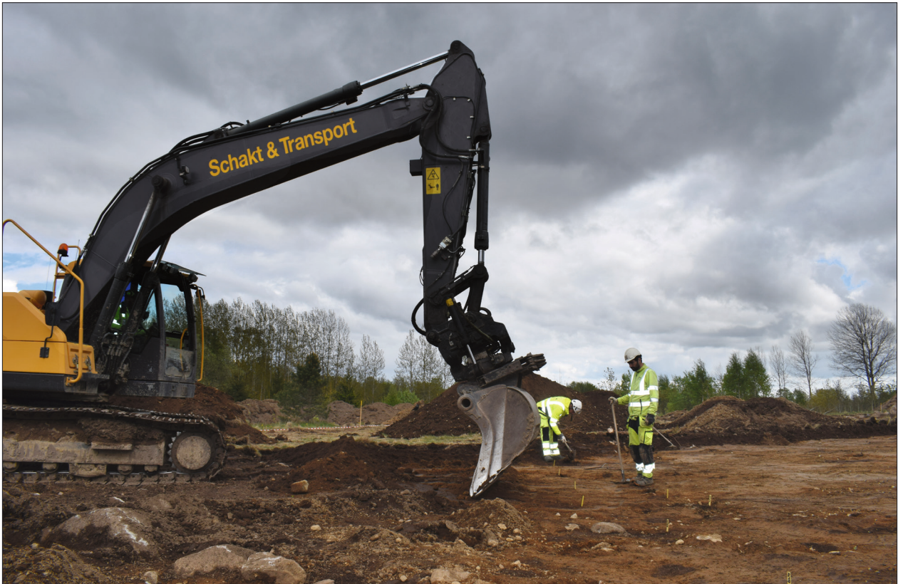
Figur 6. Avbaningen av matjorden har tagit fart. Foto: Arkeologerna.
