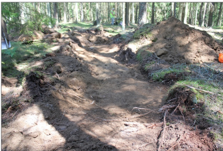
Figur 17. Schakt 5 under utredningsgrävningen, sandig morän.
