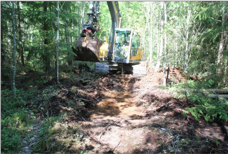
Figur 19. Schakt 6 under utredningsgrävningen
