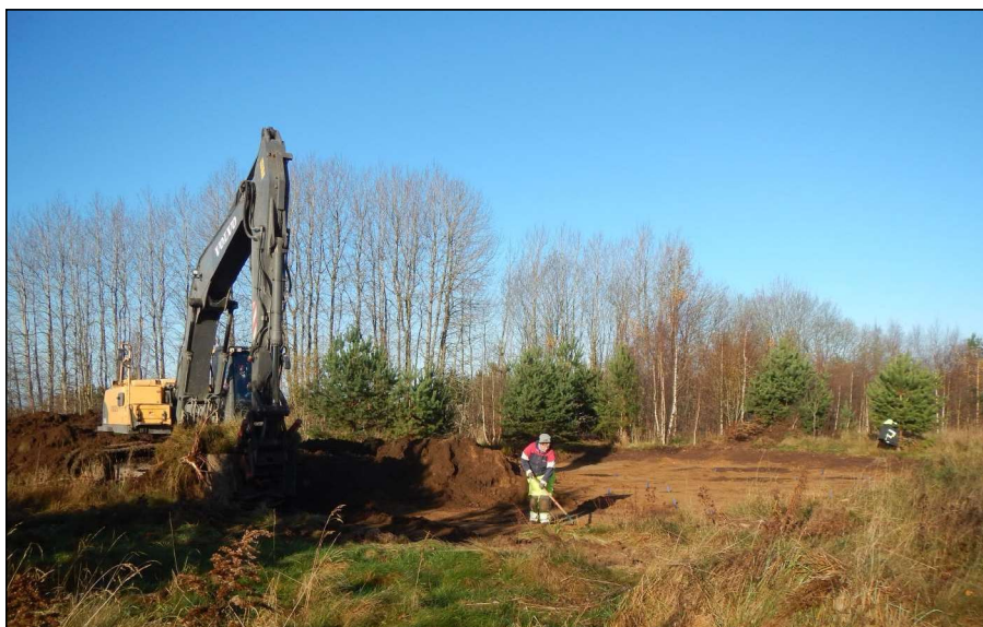
Fig. 5. Fotot visar inledningsskedet i matjordsavbaning och rensning av den fram-schaktade ytan. Foto mot nordväst.
