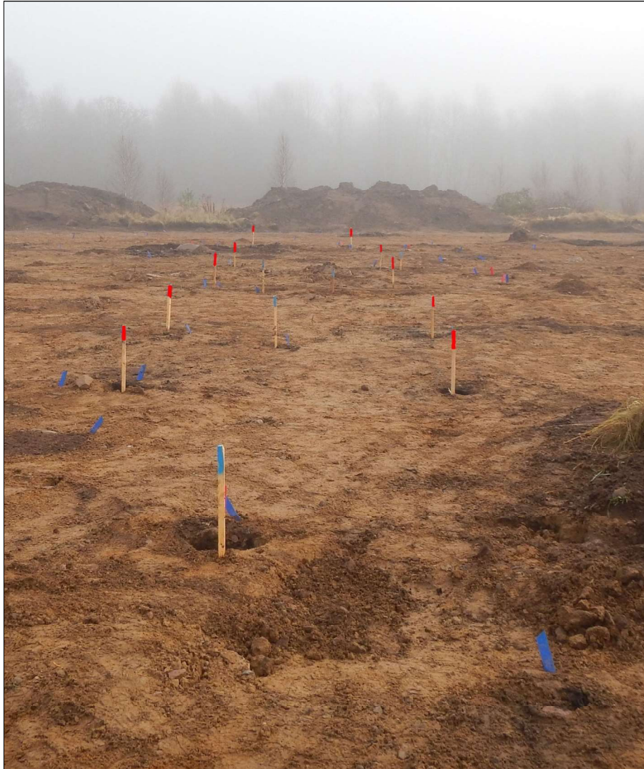
Fig. 14. Hus 4 med stolphålen efter den takbärande konstruktionen markerade med rödmålade käppar. Foto mot sydöst.
