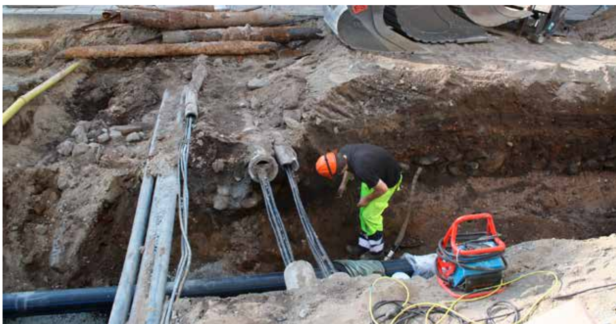
Fig. 9: Det arkeologiska arbetet gick ut på att hitta kvarlämnade spår av den äldre staden i en i ofta kraftigt skadad gatumark. Foto från korsningen Norrgatan Klostergatan med stenläggningen A3036 till höger i bild. Foto från norr.
