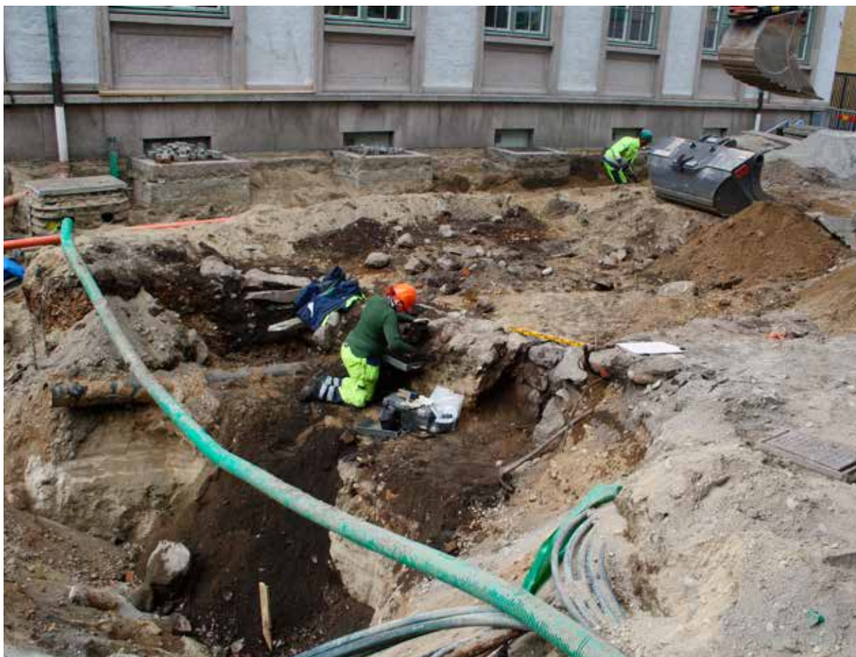
Fig. 50: Källaren A70I låg liksom många andra lämningar i en omgivning som var splittrad genom sentida ledningsgrävningar. Sandra Lundholm undersöker resterna. Foto från nordöst.
