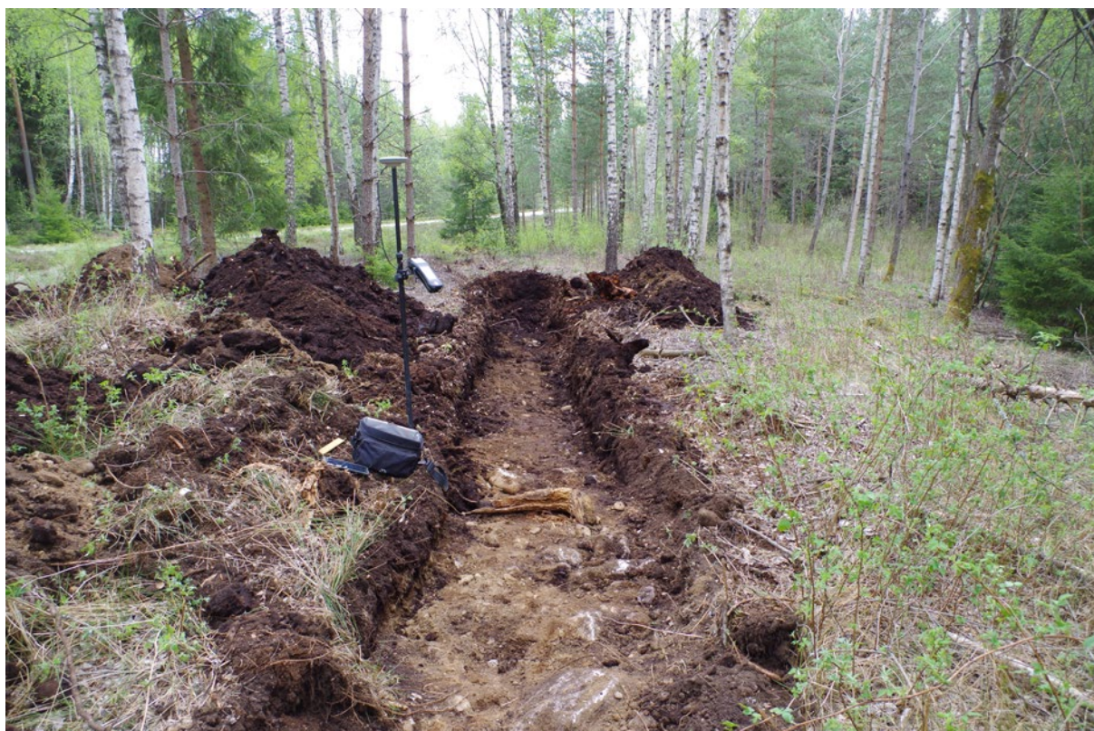
Figur 9. Schakt inom yta 5. Foto från öster.
