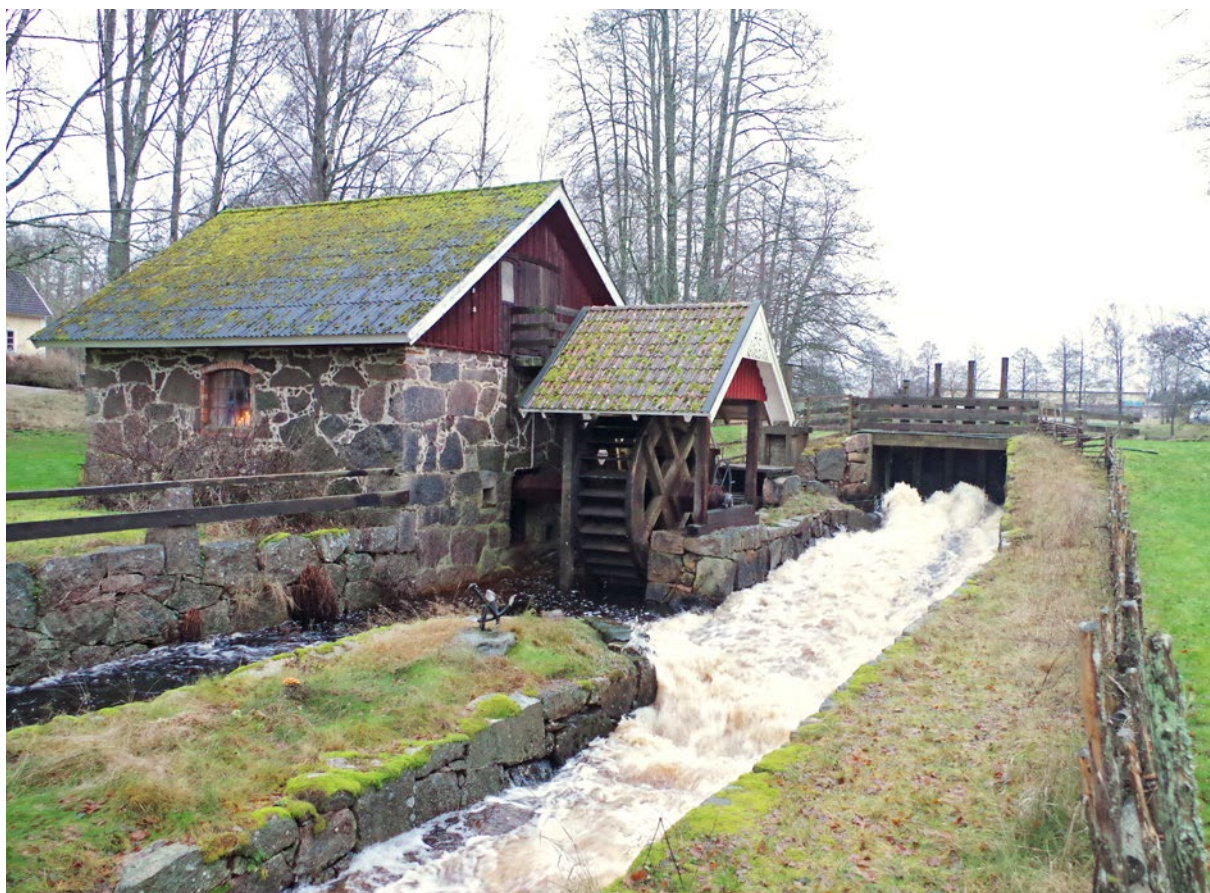
Figur 26. Redan 1476 fanns det en kvarn vid Åryd och kanske kan även annan vattendriven verksamhet funnits redan under medeltid. Bilden visar blåsmaskinhuset från slutet av 1800-talet som med sitt renoverade vattenhjul åskådliggör vattenkraftens betydelse för platsen. Foto från nordväst.
