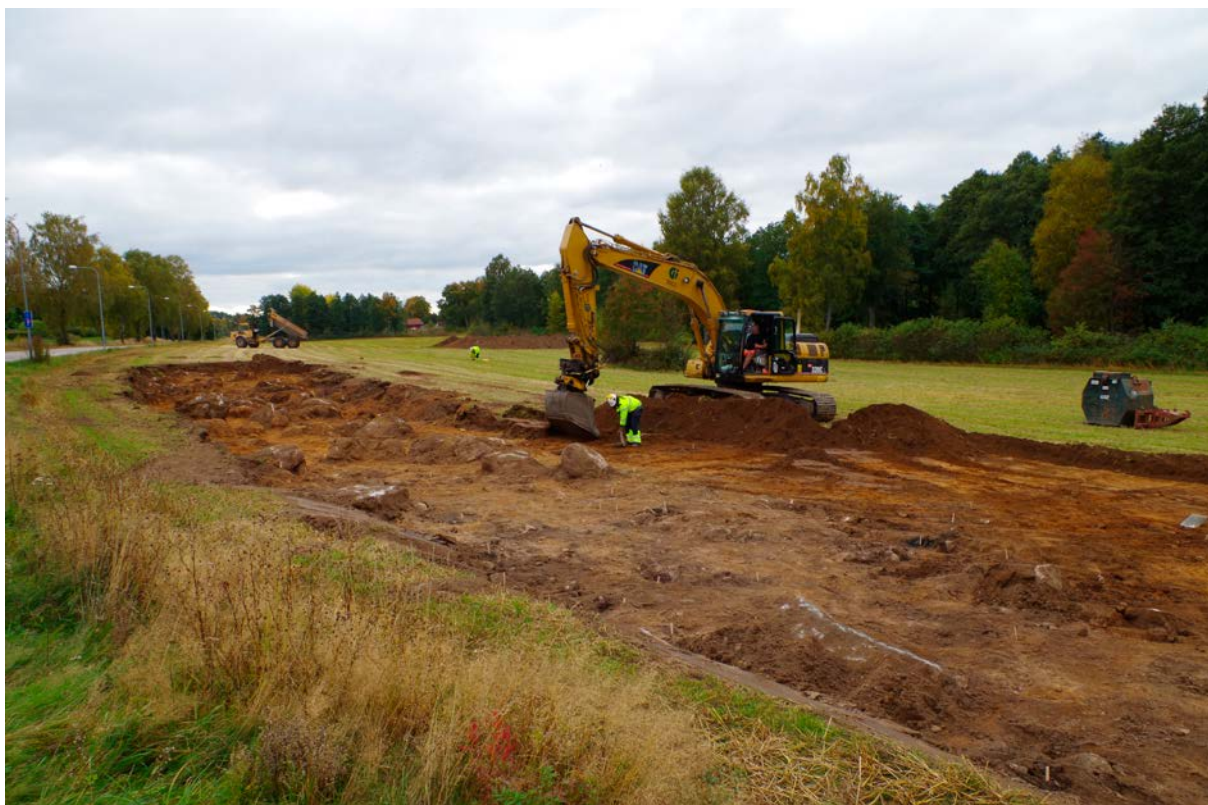
Figur 8: Matjorden tas bort med hjälp av grävmaskin i undersökningsområdets östra del. Foto taget från nordöst.
