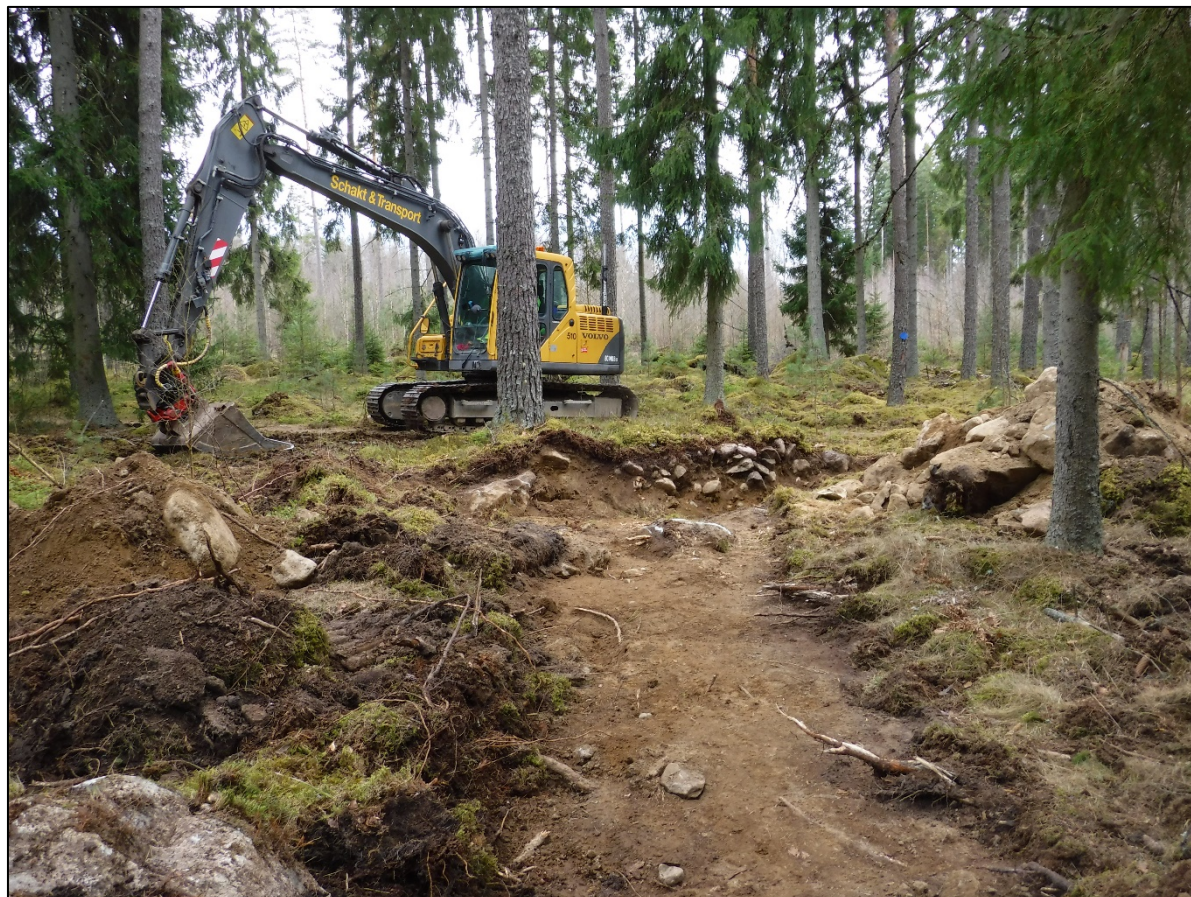
Figur 17. Schakt S8 med A104 längst mot grävmaskinen och A105 i västra kanten (ligger mot stenblocket).
