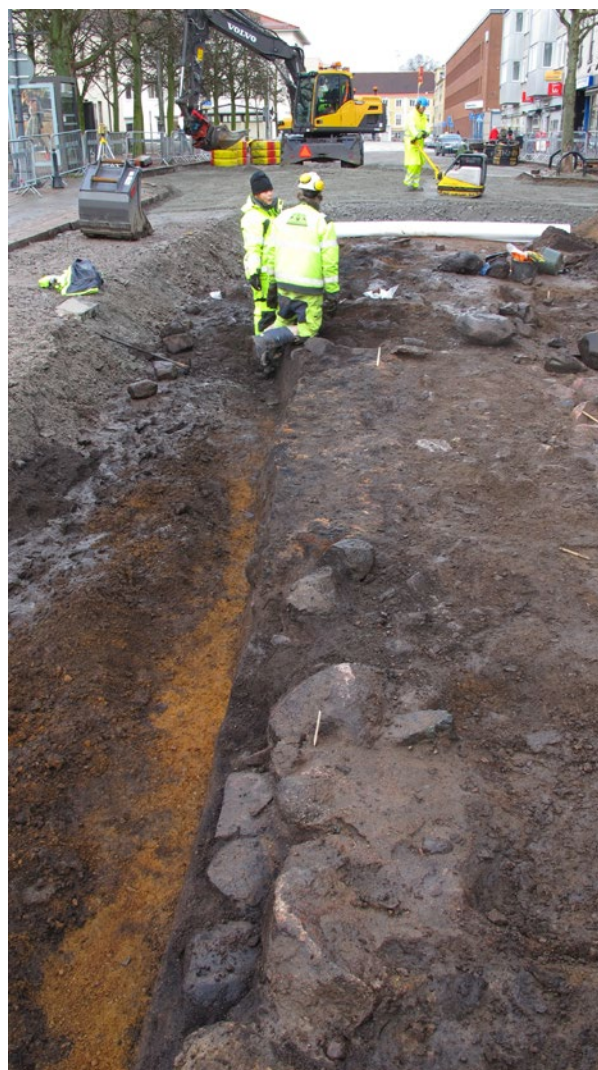
Figur 42. Bebyggelselämningarna från fas 3 i undersökningsområdets sydvästra del var enbart bevarade inom en långsmal remsa mellan den yngre bebyggelsen i väster och den äldre gatan i öster. Foto taget från söder.
