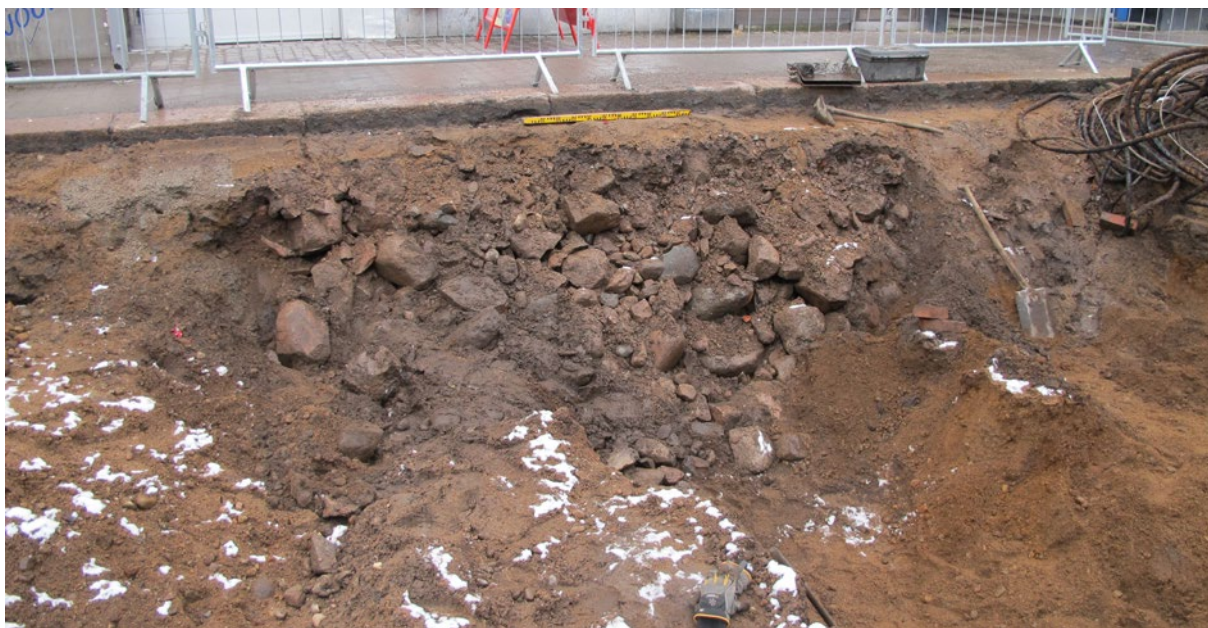
Figur 35. I schaktkanten i undersökningsområdets nordöstra del fanns en stenfyllning, A408, som bör höra samman med en källare från tiden före 1658. Foto taget från väster.
