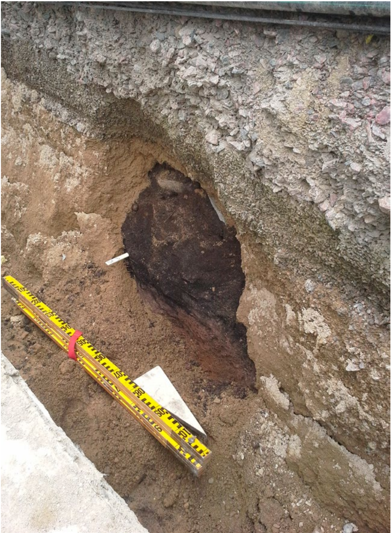
Figur 9. Grävningen gjorde i huvudsak i det gamla fjärrvärmeschaktet. I vissa partier frilades bevarade kulturlager i schaktväggen. På bilden ser man att fjärrvärmeschaktets grusfyllning rasat ut och att kulturlagren utanför schaktet framträder.
