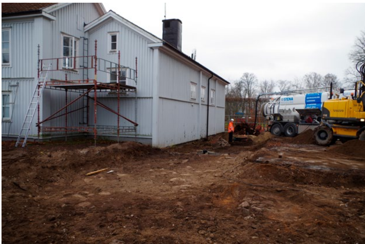
Figur 35: Vid undersökningen frilades den södra delen av Gravaregårdens långa uthus som bör ha använts i garveriverksamheten. Foto från nordväst.
