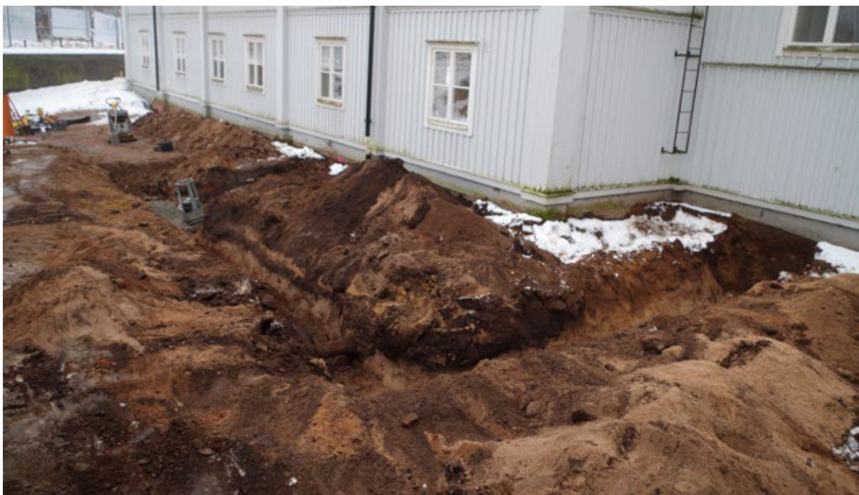
Figur 29: I schakten för dagvattenledningar kunde man se att bottenlagren närmast huvudbyggnaden utgjordes av odlingslager och underst vattenavsatta lager. Foto från nordväst.
