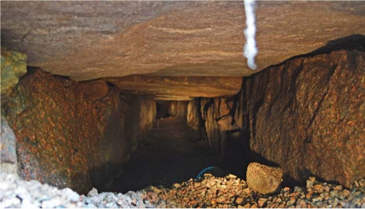
Fig. 11: A733 var en stenbyggd, täckt vattenledning, troligen från omkring 1900, som var öppen så långt man kunde se i ficklampsljuset. Foto från söder.
