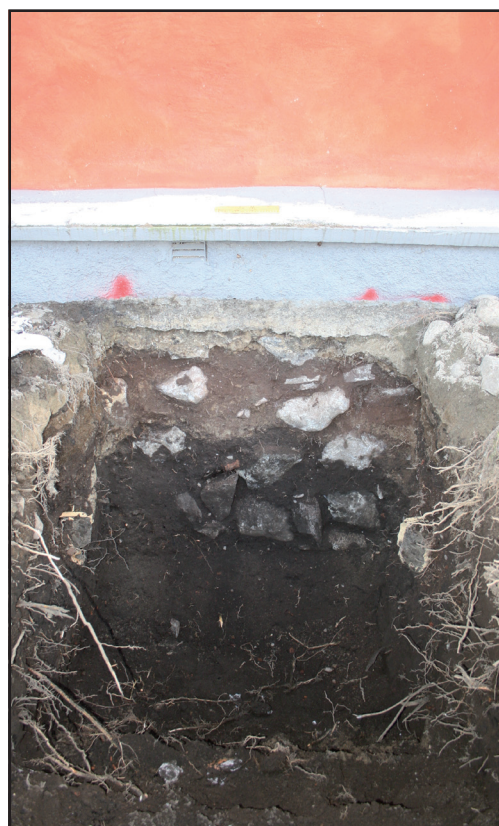
Figur 11 visar ett foto av grundmuren i schakt 268 mot söder.
