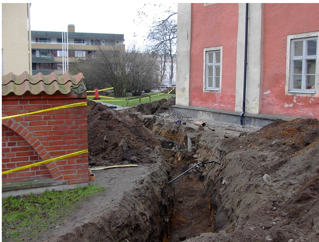
Fig. 6: Schaktgrävningen väster om Karolinerhuset 2003. Här fanns bevarade byggnadslämningar och kulturlager. Bild tagen från sydväst.
