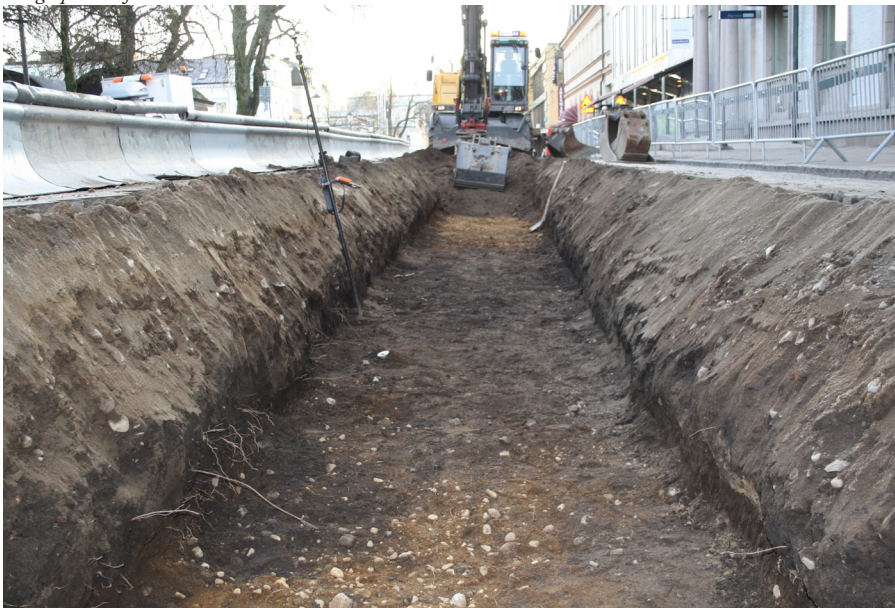
Figur 41: I Kungsgatan fanns delvis bevarade kulturlager, förmodligen odlingslager, i botten av schaktet. Foto från N.
