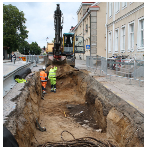
Figur 7: Källaren A199 och ledningsschaktet från S.
