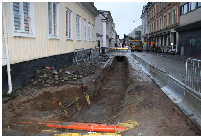
Figur 44: Schaktet i Sandgärdsgatan. Foto från Ö.
