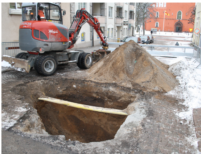
Figur 9: Serviceschakt i Sandgärdsgatan öster om Kronobergsgatan, yta med orörda lager i gatans mitt. Foto från V.
