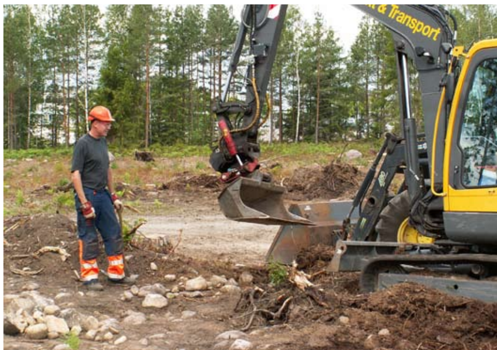
Figur 79. Richard Wennerberg vid grävmaskinen
