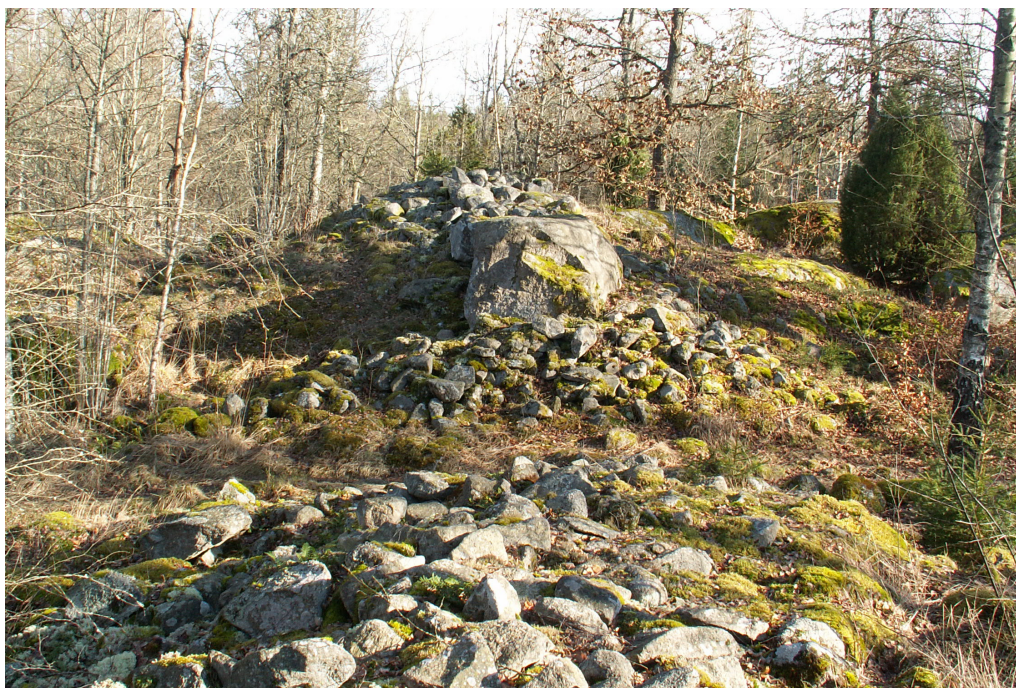
Fig 3. Gripebergs norra mur. På bilden syns ingången genom muren där det i dagsläget går en stig. Foto taget mot öster.
