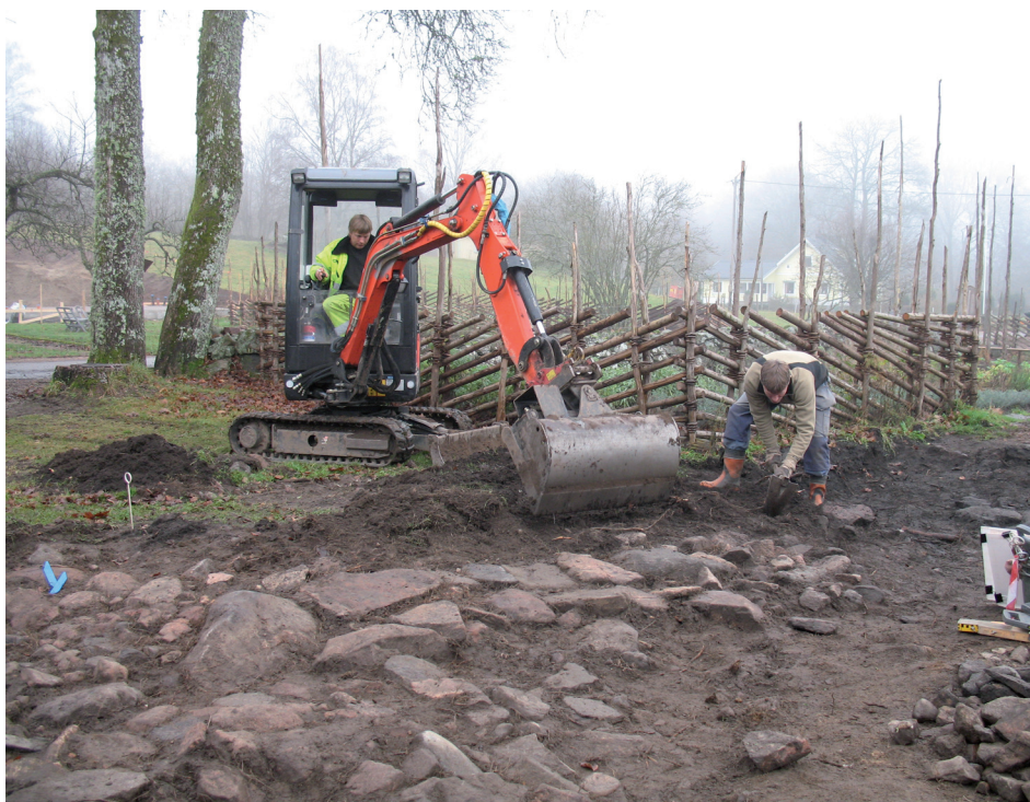
Fig 4. Maskinavbaning i nordöstra hörnet av gårdsplanen. Foto från NV
