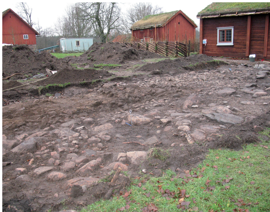
Fig 10. Frilägningsarbetet påbörjades i norr. Här är den första etappen frilagd och framrensad. Foto från NO.
