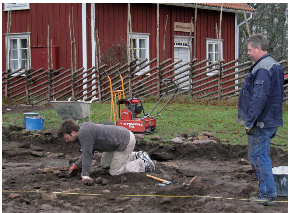
Fig 28. Sten och Stanley lägger kullersten inom gårdsplanens norra del.
