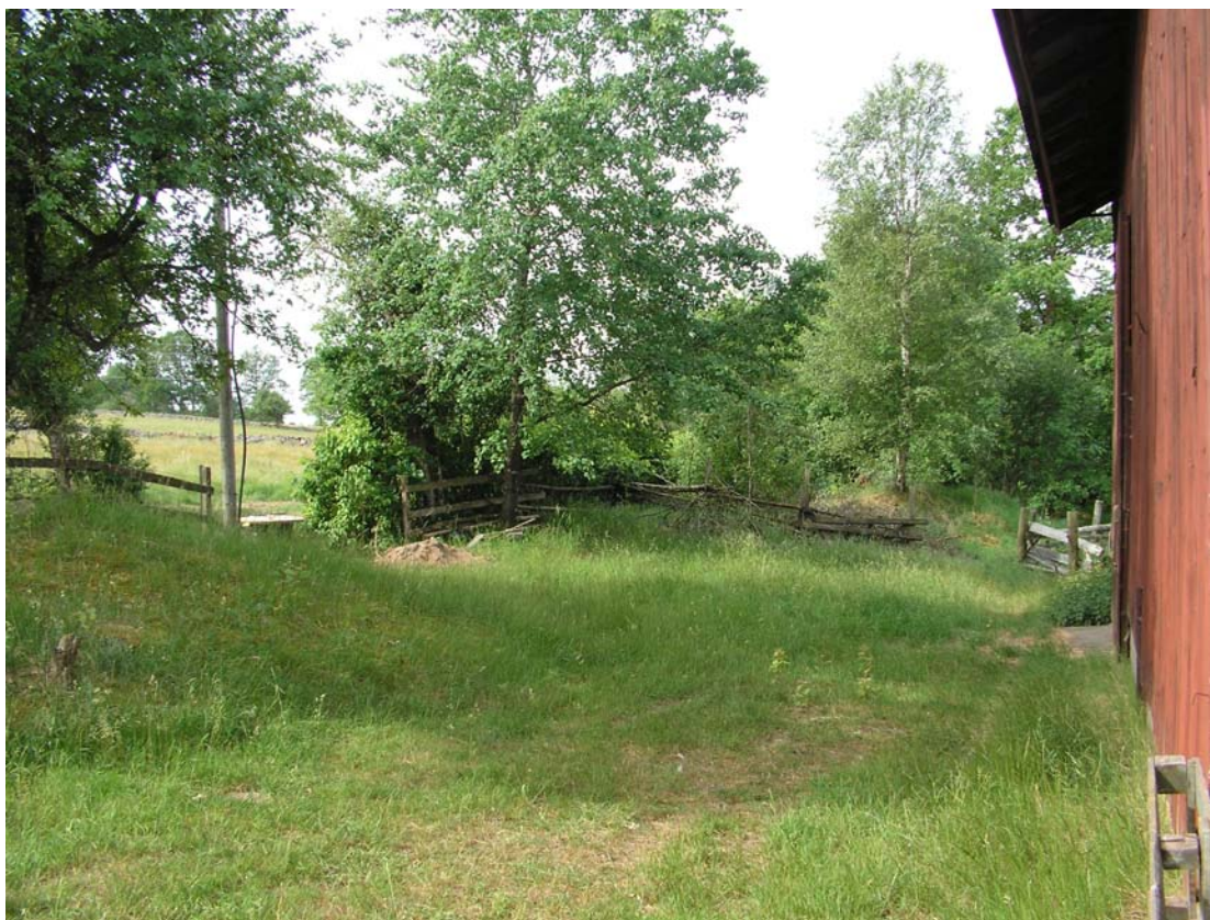
Fig. 4 Platsen före schaktning. Lagg märke till gravhögarna på ömse sidor om grindhålet.. Foto från N.
