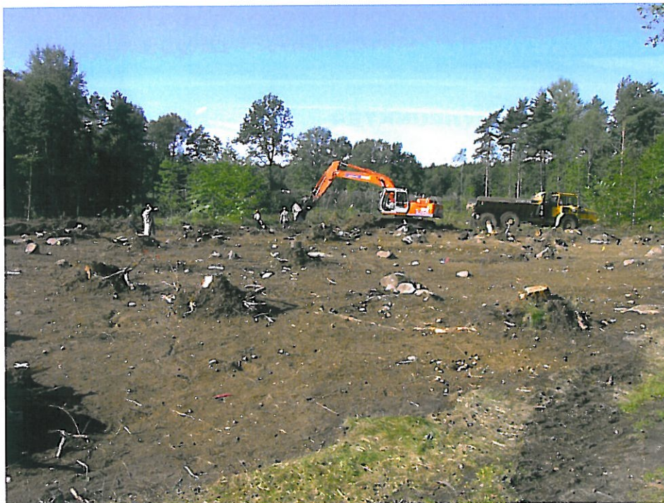
Fig 11. Schaktning av undersökningsområdet. Foto mot sydväst.
