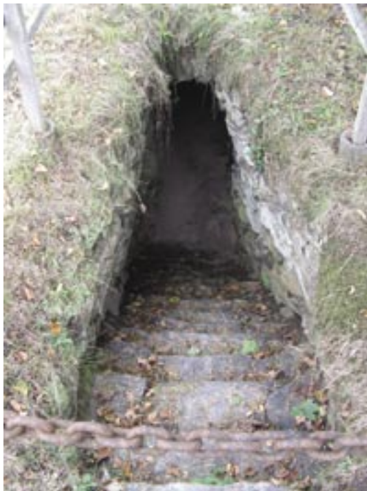
Fig. 16. Källartrappan ned till den tunnvalvda källaren. Foto M Hansson.
