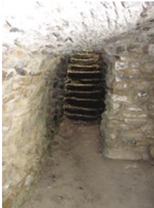
Fig. 17. Källartrappan och delar av murverket inifrån källaren. Foto M Hansson.
