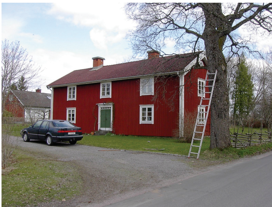
Fig 19. Mangårdsbyggnad vid Svengård. Foto Johan Åstrand.
