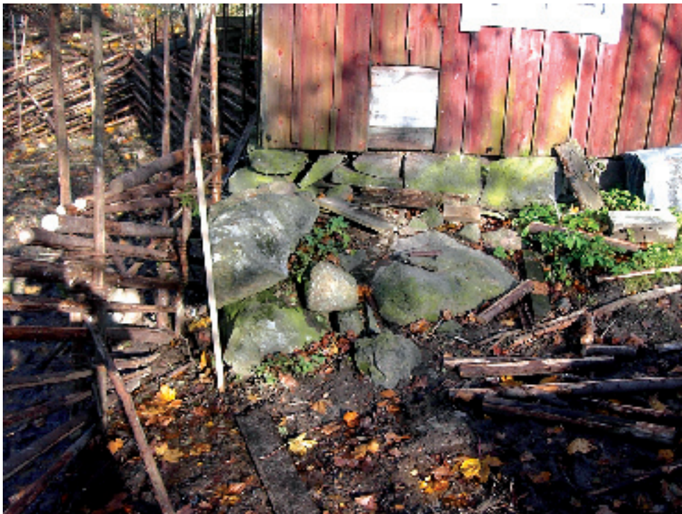
Figur 12. Den kraftiga stengrunden under det nuvarande hönshuset. Foto mot norr.
