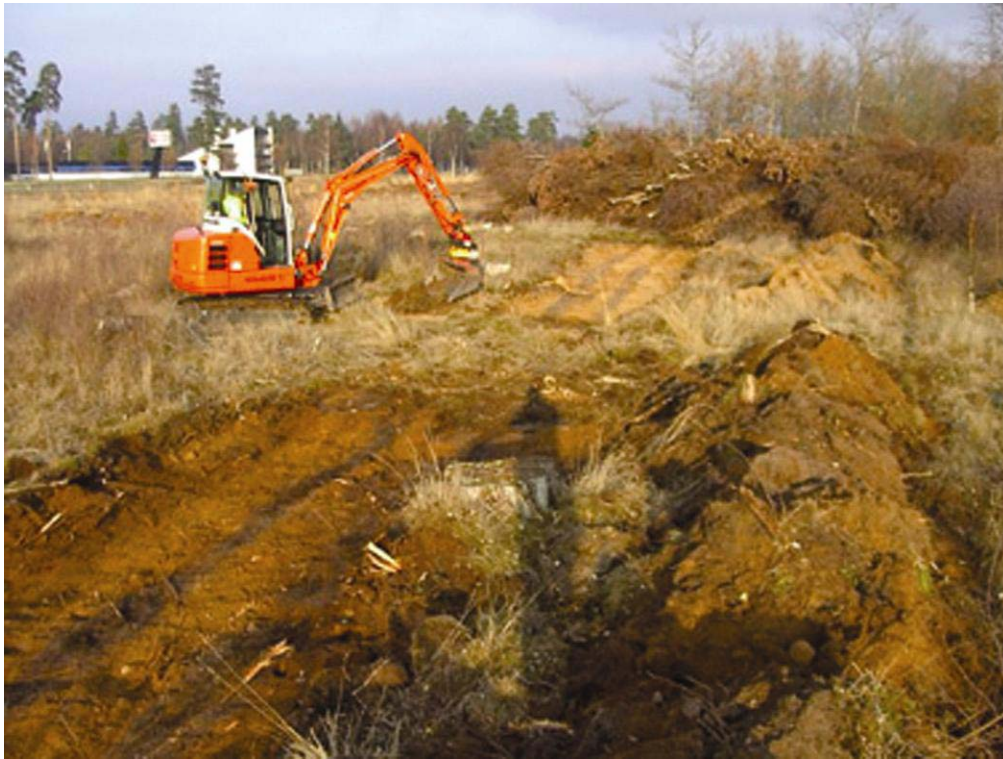
Figur 14. Väg C i två av söschakten. Foto från sydväst av Jessica Wennerlund.
