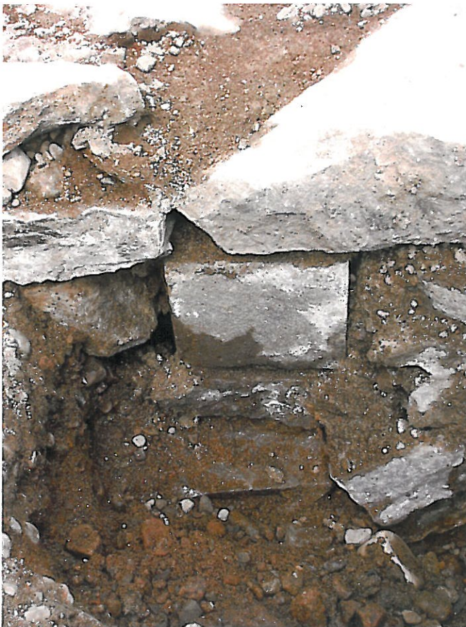
Fig. 11 I bildens mitt syns kvadern i husets grundmur. Foto från öster, Martin Hansson.
