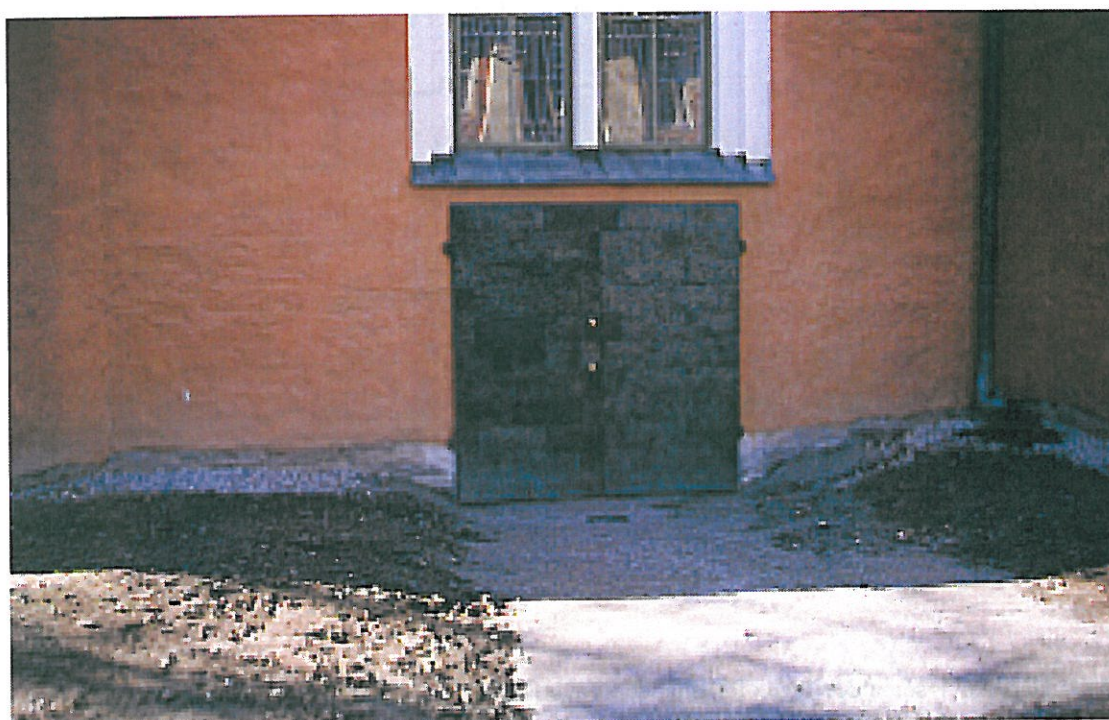
Den färdiga dörrinstallationen
