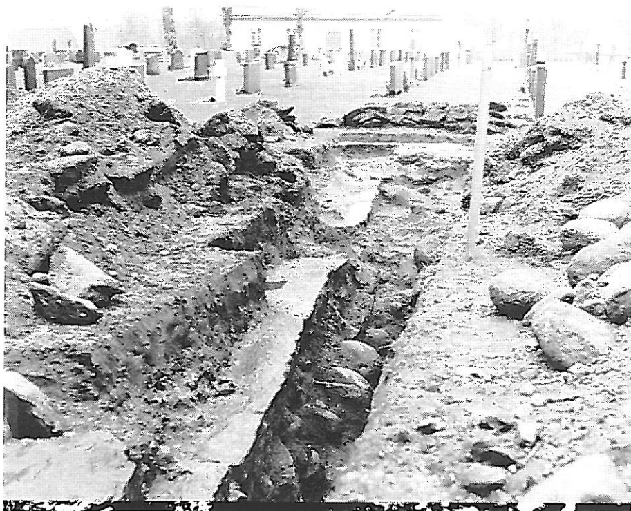
Fig 9. Långhusets västmur med grundmuren synlig under hållarna. Foto mot sydöst.
