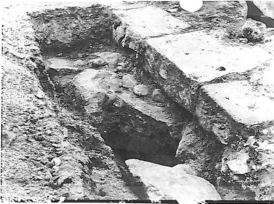
Fig 8. Tornets sydvästra hörn med blottad grundmur under de tuktade hällarna. Till höger längst ned i bild framskymtar dagermurens skadade hörn. Foto mot nordöst.
