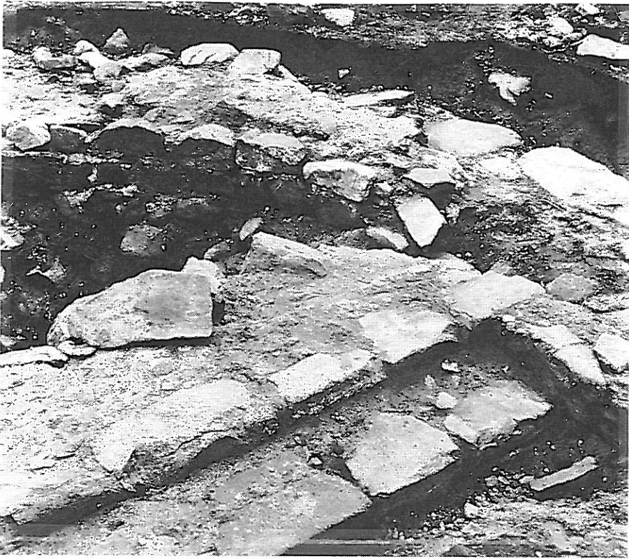
Fig 18. Anslutningspartiet mellan kor och absid. Foto från NV.
