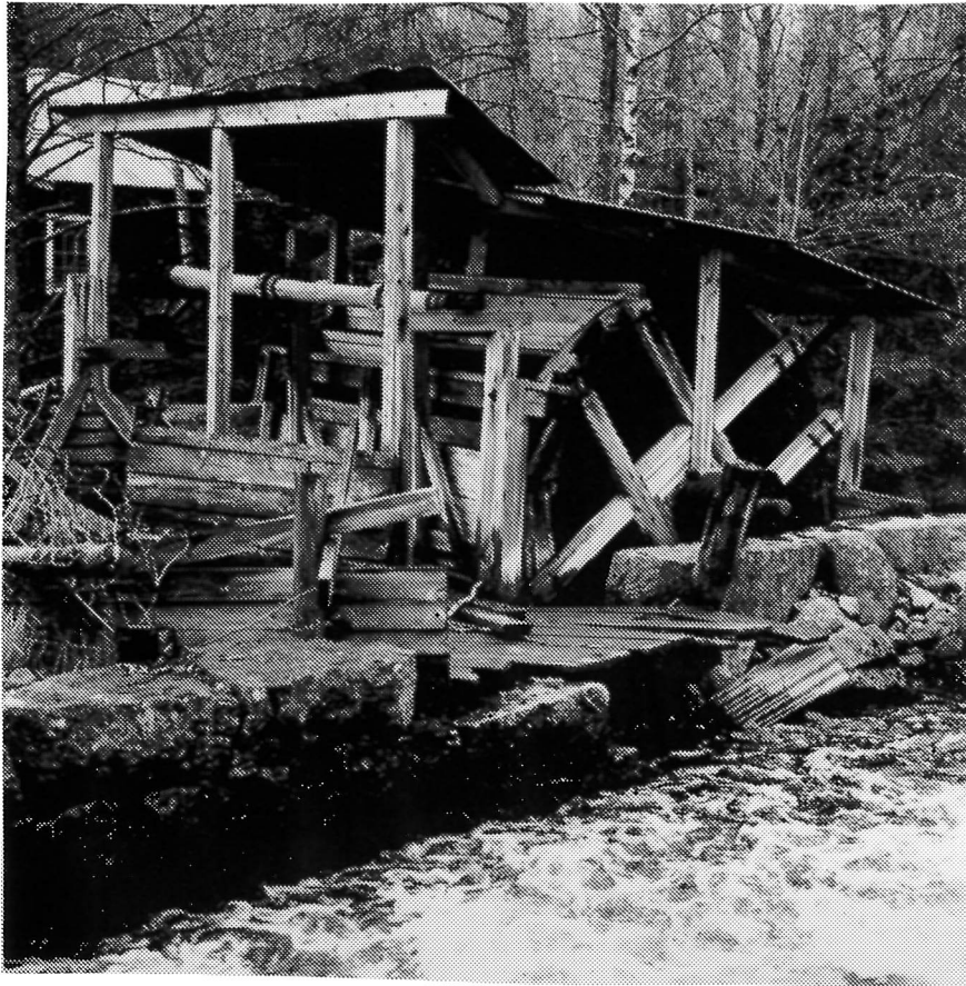
Fig.19. Vattenhjulet vid Horkoneryds såg, ett s.k. underfallshjul, där vattnet träffade hjulets skovlar underifrån.
