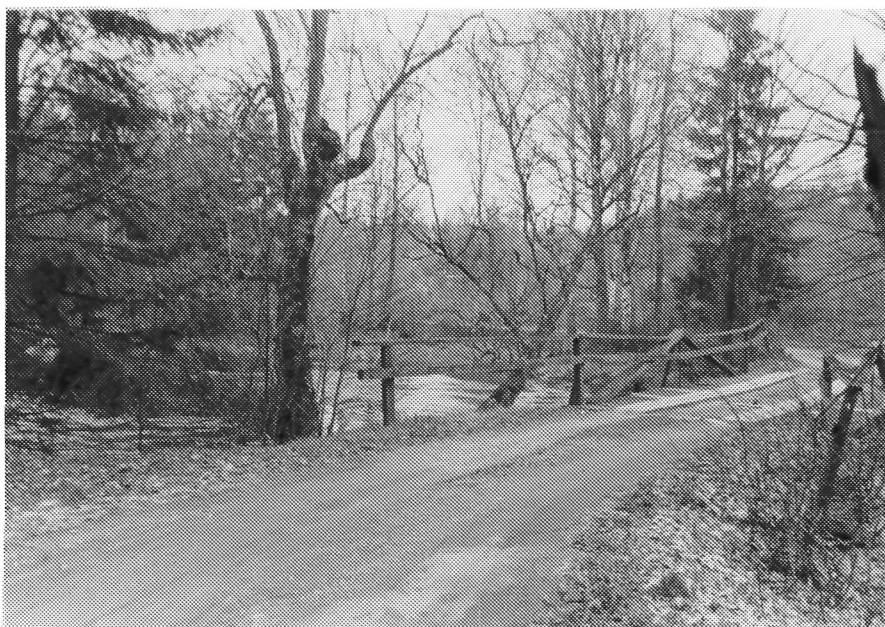
Fig.28. Vägen och bron över över Ronnebyån i Skallevraket.
